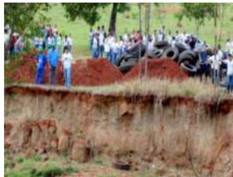
Figura 06 – Pneus recolhidos pela SUCAM e preparo do solo para a contenção.
