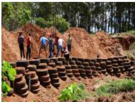
Figura 8 – Preparo, enfileiramento e cobertura dos pneus para contenção da erosão.
